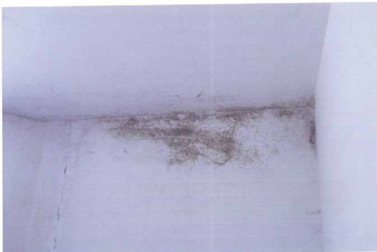
FOTO N.7 = PARETE NORD DELL'UFFICIO.
