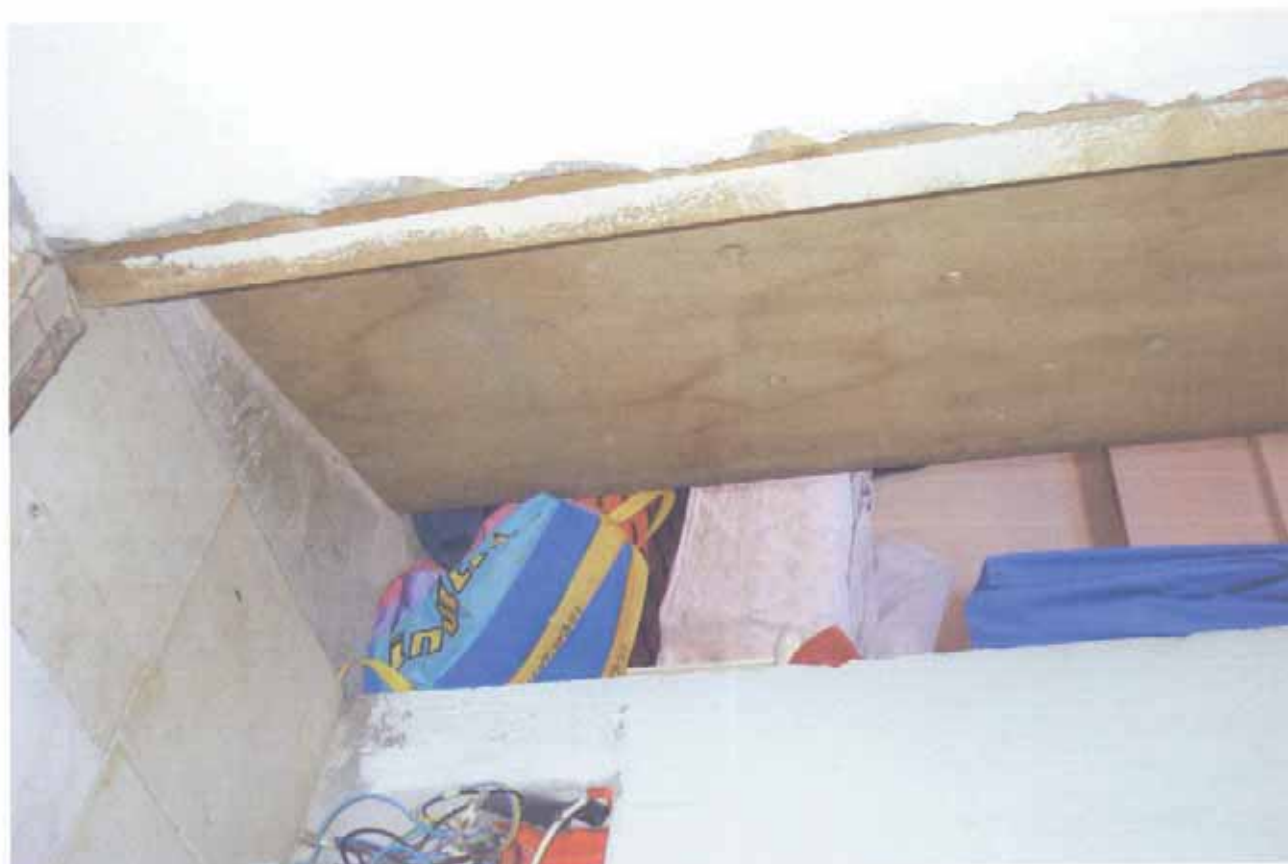
FOTO N.23 = DISIMPEGNO SOTTOTETTO DELL' ARCHIVIO.
