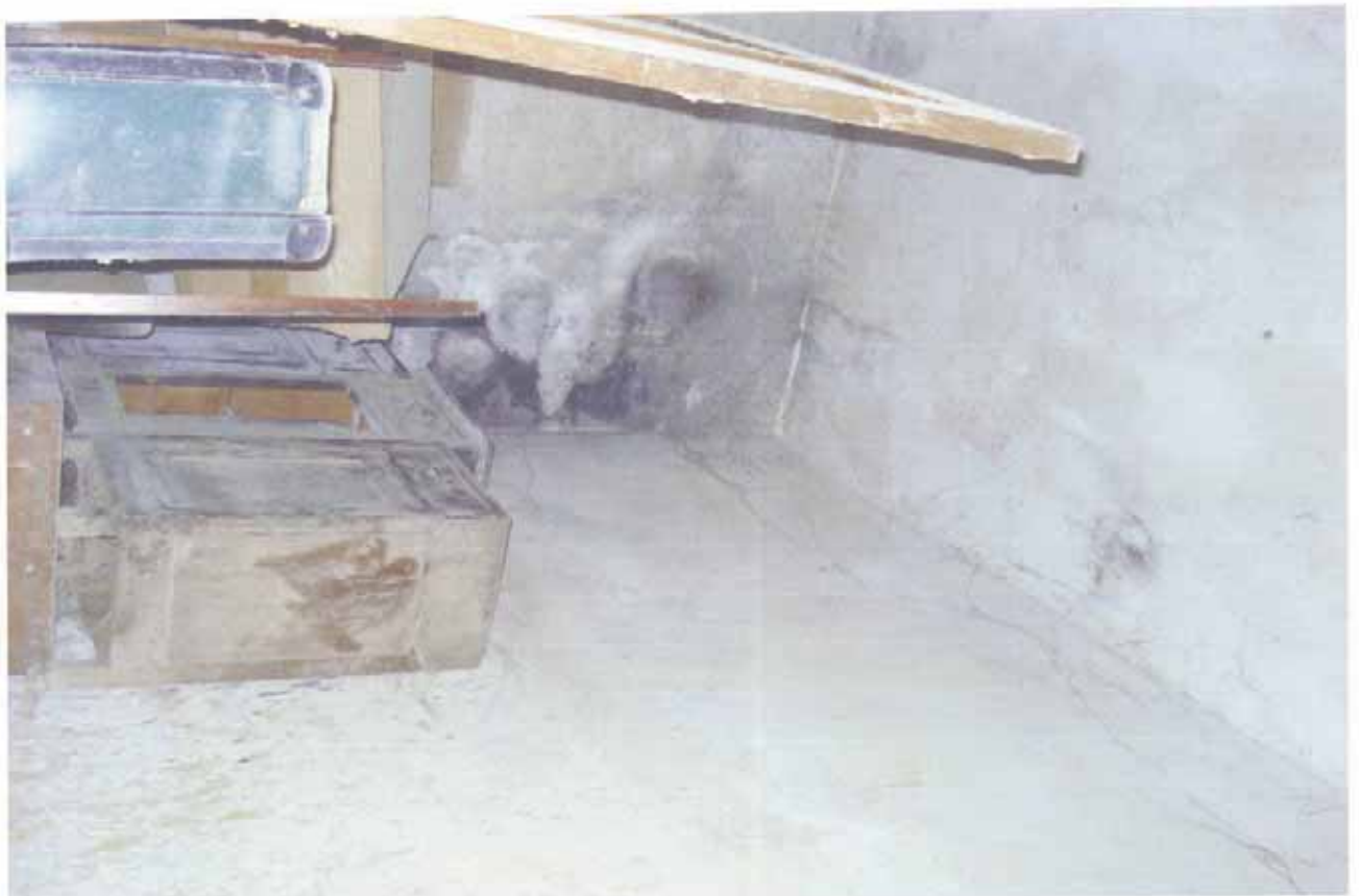
FOTO N.13 = INTERNO DELLO SPOGLIATOIO ANGOLO NORD - OVEST.
