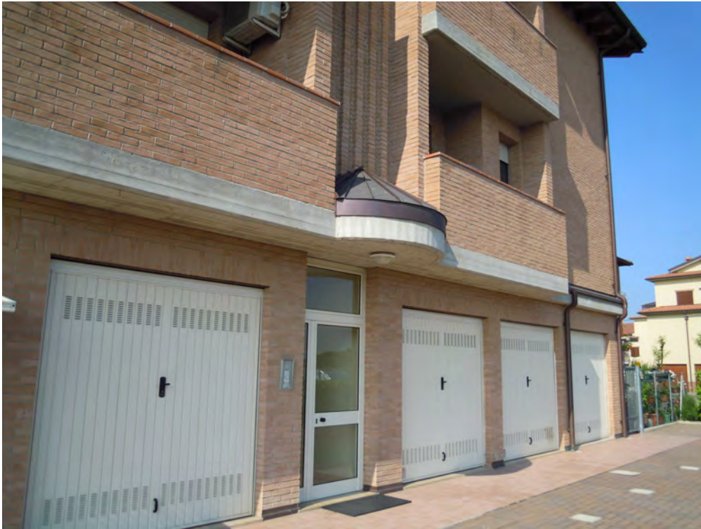
Figura 1 - FRONTE PRINCIPALE FABBRICATO
